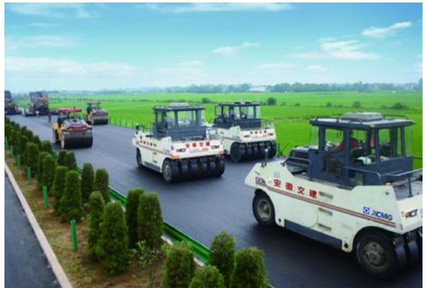
图为公司施工现场
