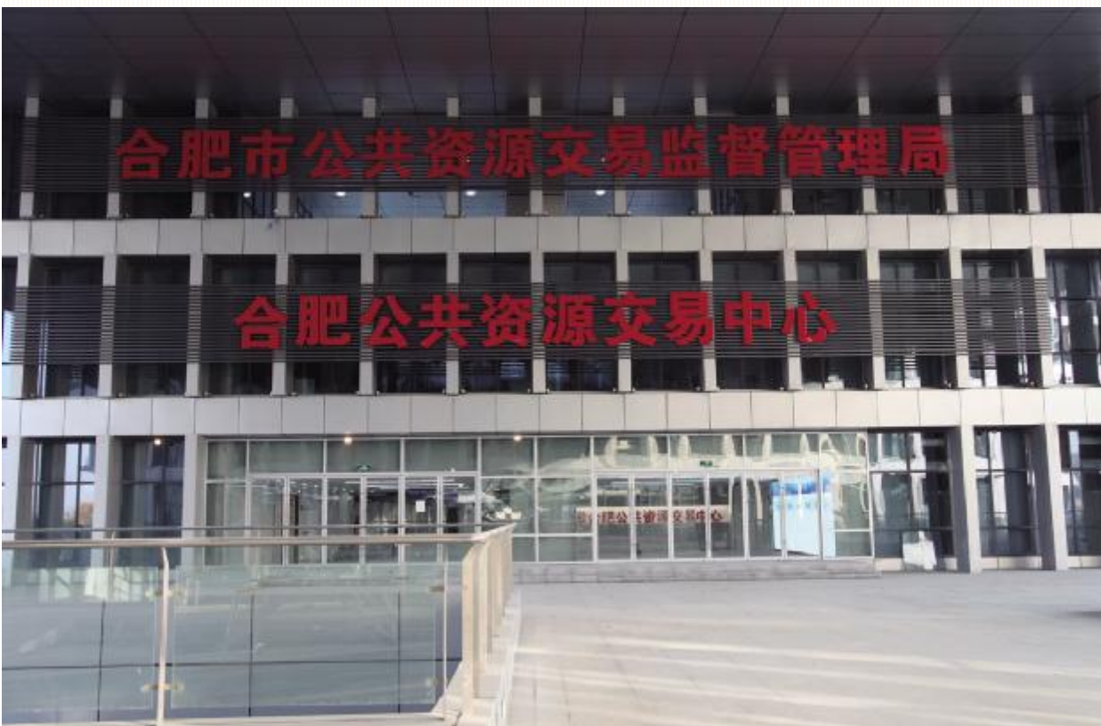
局、中心办公服务新址：总面积约 3.1 万平方米，设对外咨询服务大厅、网上办事大厅、信息发布区、开标评标区、隔夜评标区、拍卖大厅、电子竞价室、谈判室、监控室、大宗样品室、专家抽取室、会员区等。
