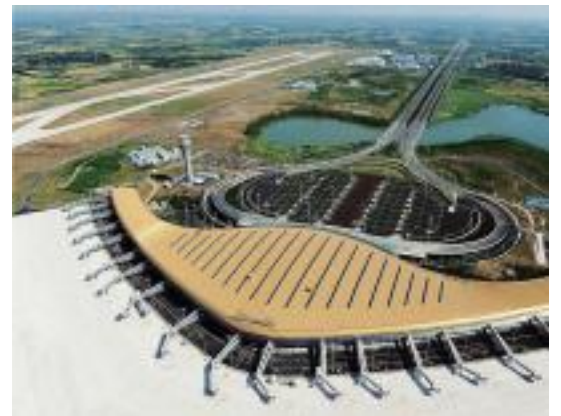
▲新桥机场航站楼
