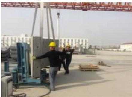
在水下养护14天，起水放置在室外存放14天，共计28天后，管片就可以出厂下井安装了。
