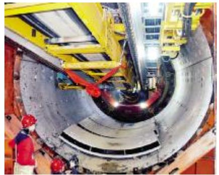
管片被运至地下后，大型盾构机已经在此等候多时了。灵巧的机械臂将管片恰当地拼装成环，再经过多道工序，管片安装就完成了。
